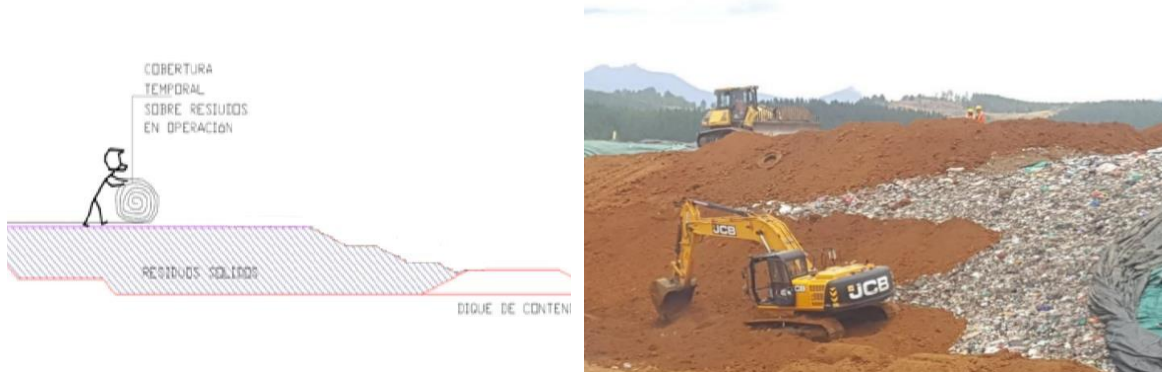
Figura 8. Esquema proceso recubrimiento diario de los residuos.
